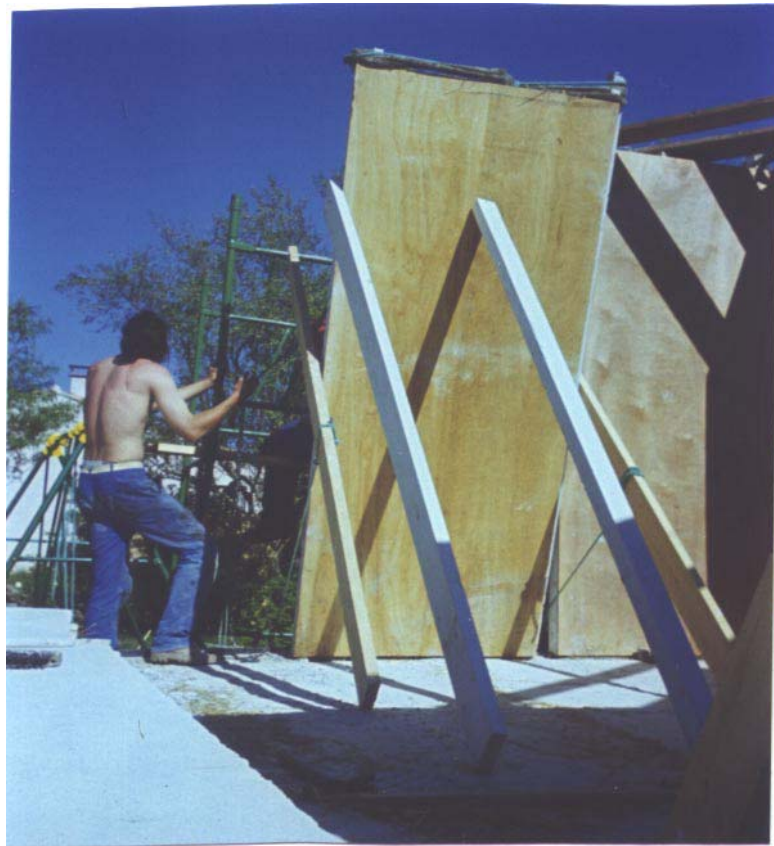
Photo 8 Coffrage des poteaux d'angles en béton. Utiliser des pointes de 100 pour faire la liaison avec les panneaux. Commencer la maison par les angles et fixer des bois
