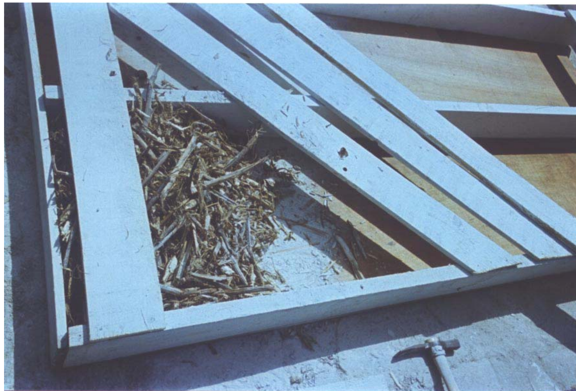
Sur construction antisismique, méthode des panneaux
