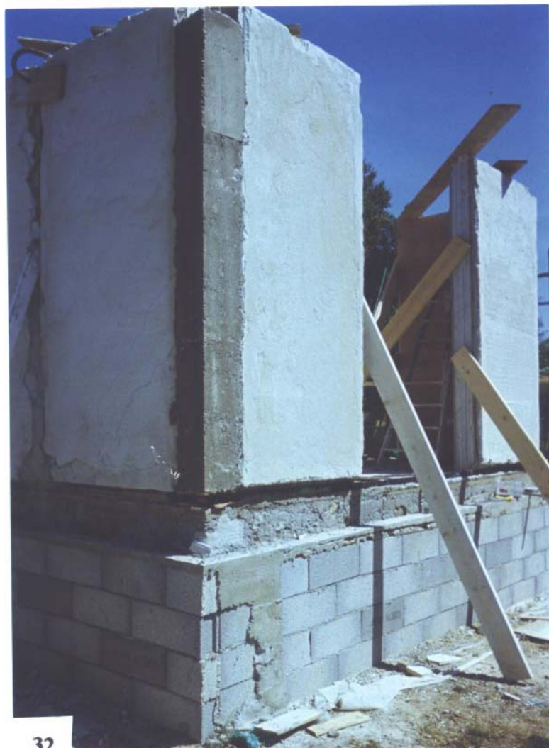
Photo 8 Coffrage des poteaux d'angles en béton. Utiliser des pointes de 100 pour faire la liaison avec les panneaux. Commencer la maison par les angles et fixer des bois
